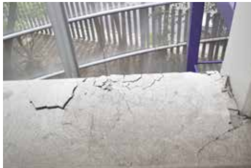
Fachada Lateral del Edificio Sede
