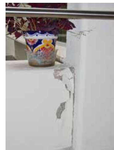
Muro y Columna del 2° Piso
