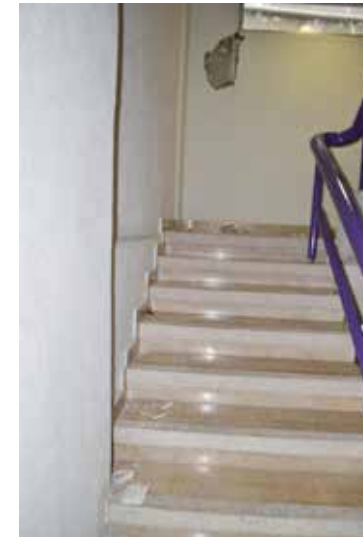
Escaleras del 1° al 2° Piso
