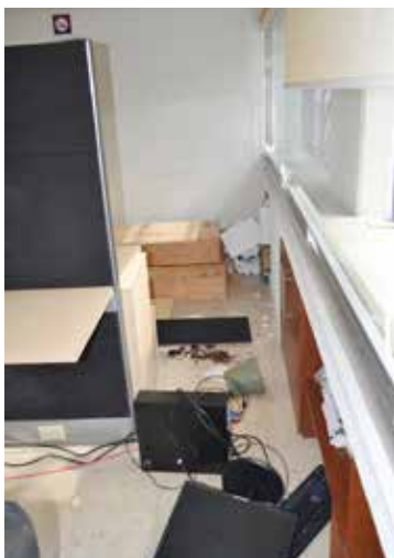
Pasillo del 4° Piso
